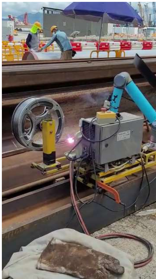
Robotic Welding in ELS works [NL/2020/03]
