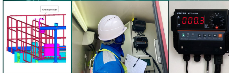
當風速達到每小時41公里或每秒11米38時，龍門式起重機將暫停運作
