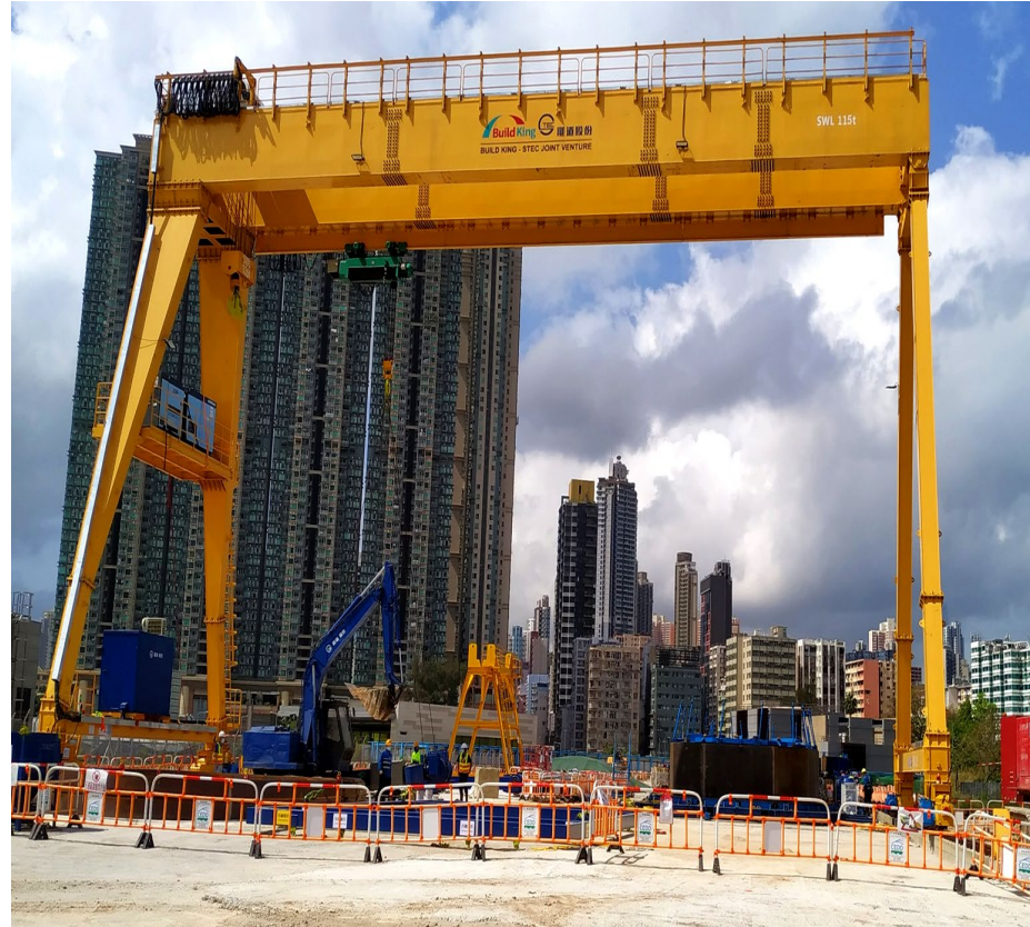
115公噸龍門式起重機 (吊運預製組件)
