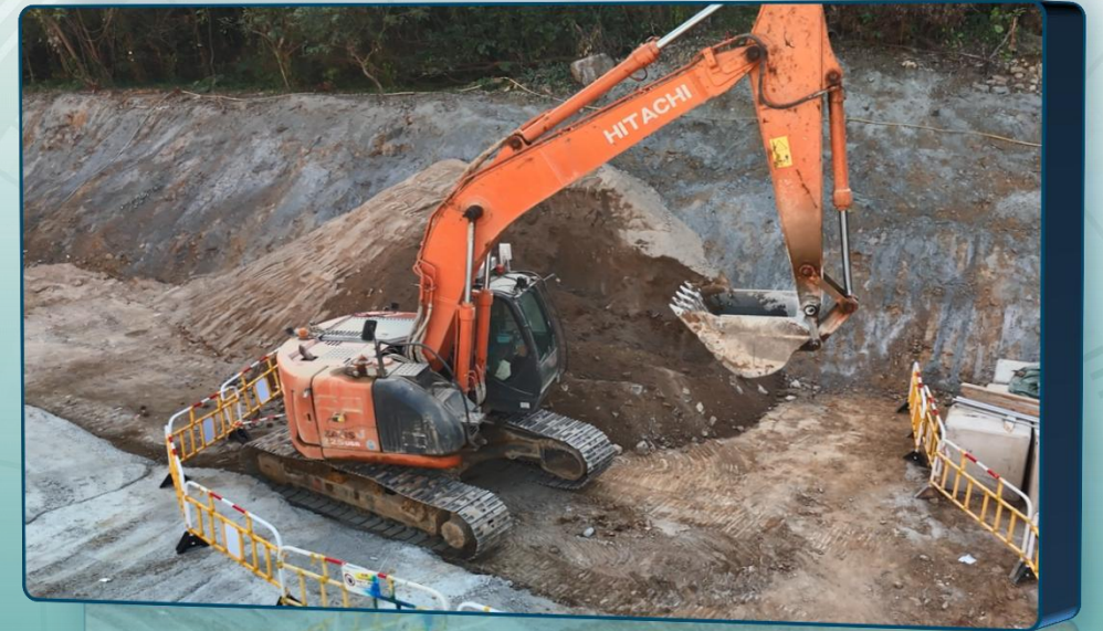
遠程操控挖掘機系統
