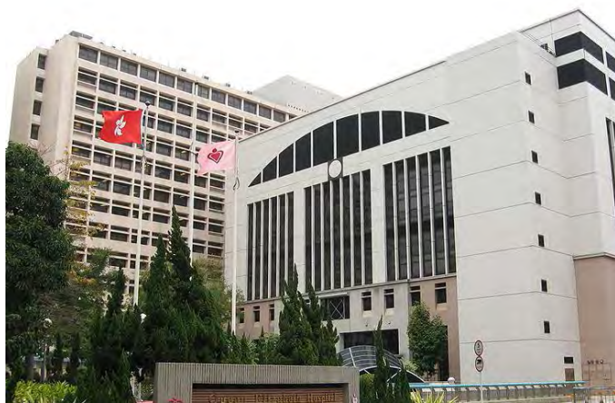
樓宇翻新及裝修
