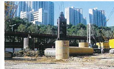
實施五常法後，地盤變得更整潔安全
