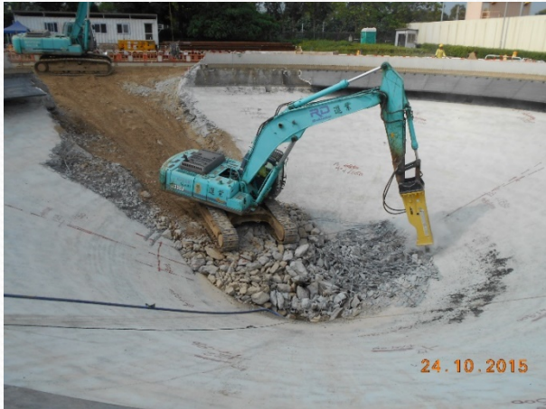
Demolition of Existing FST
