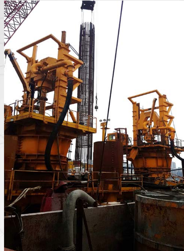
鑽樁機四邊已安裝圍欄及通道
