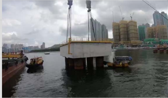
第2步: 於海上樁帽施工
