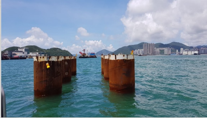
第1步: 在海上建造鑽孔樁
