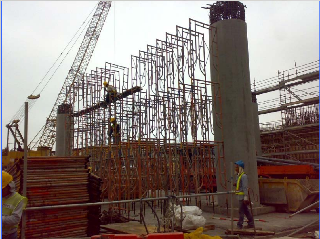
工程控制 - 傳統模板及臨時工序的搭建
