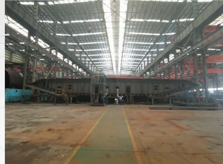
已完成部份鋼鐵橋的組件
