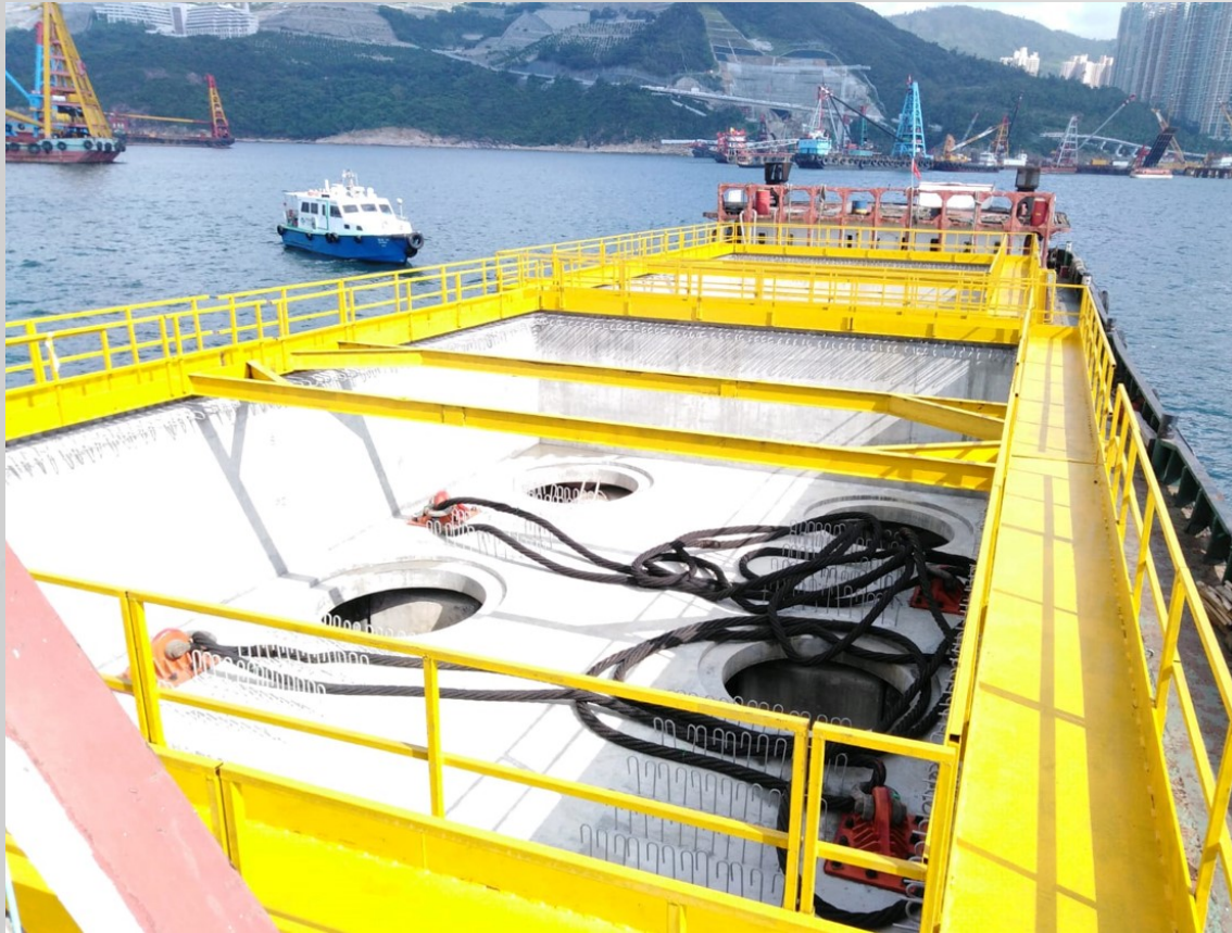
預製混凝土樁帽外殼已在廠內安裝安全通道、圍欄及踢腳板
