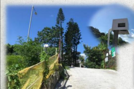
於石屎斜路入口放置閃燈警報裝置嚴格控制出入車輛。
