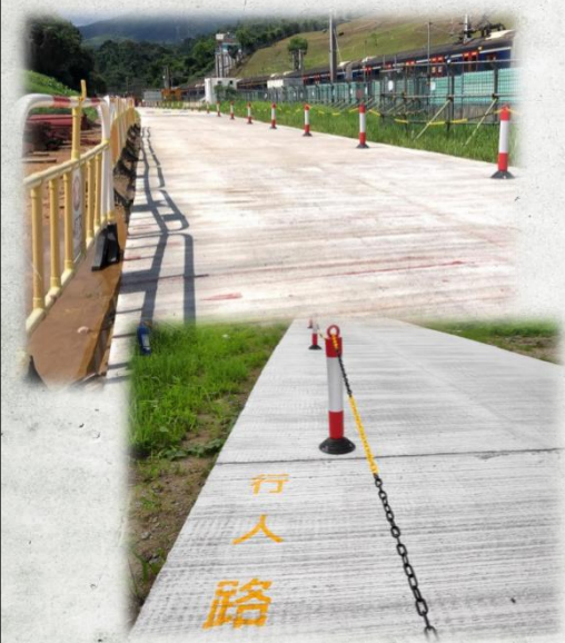
於新造的石屎路實施人車分隔，並以黃/黑鍊分隔車路和行人路，防止工友被車輛撞到。
