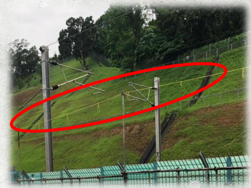
以黃繩製作界限標示，警示吊運範圍不得進入2.75米最起碼安全距離。
