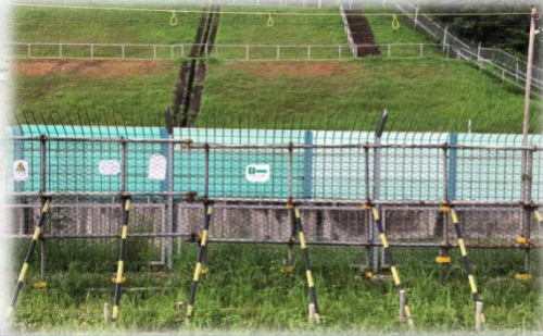
鐵網圍欄的斜撐塗上黃/黑警示顏色，防止工友絆倒。
