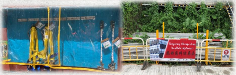
手工工具存放板，根據大小整齊掛起，使用時得心應手；全身式安全帶存放板，安全帶井井有條地掛起，有名有家，方便檢查；物料分類整齊擺放，方便存取。
